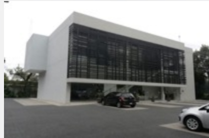
Diseño, construcción e instalación del Laboratorio de Electrónica Digital Avanzada del STCM
